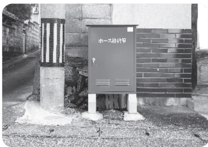
新調された格納箱。五反地に計8カ所ある。
